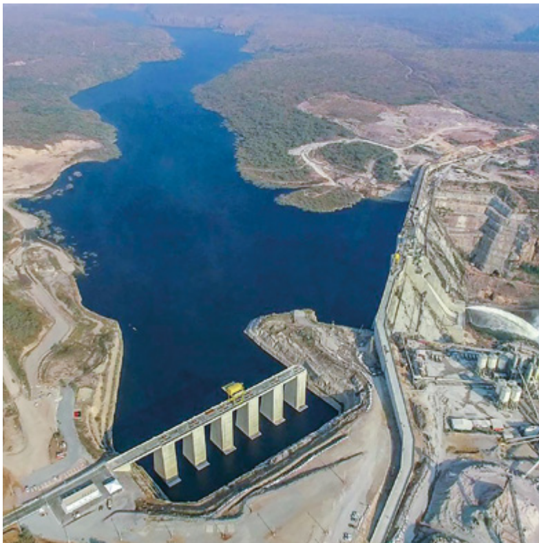
Vista del área de presa y casa de máquinas
