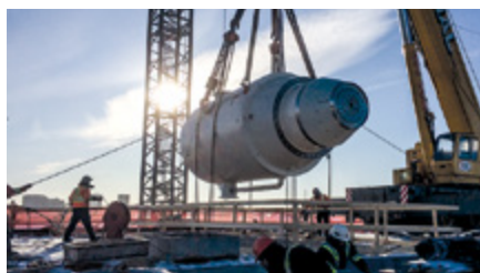
Instalación de turbina tipo bulbo
