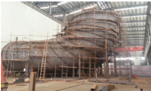
Instalación de tubo de aspiración
