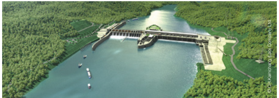
Esclusa de navegación, vertedero, bloque intermedio, central y escalera para peces
