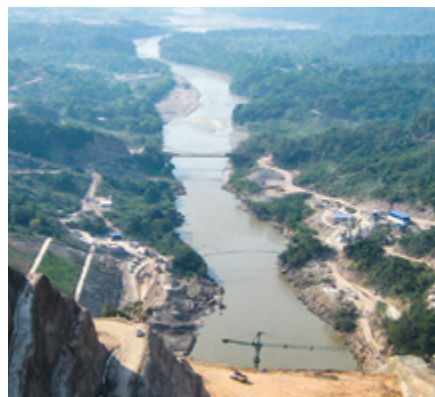
Vista aérea del sitio de construcción y del río
